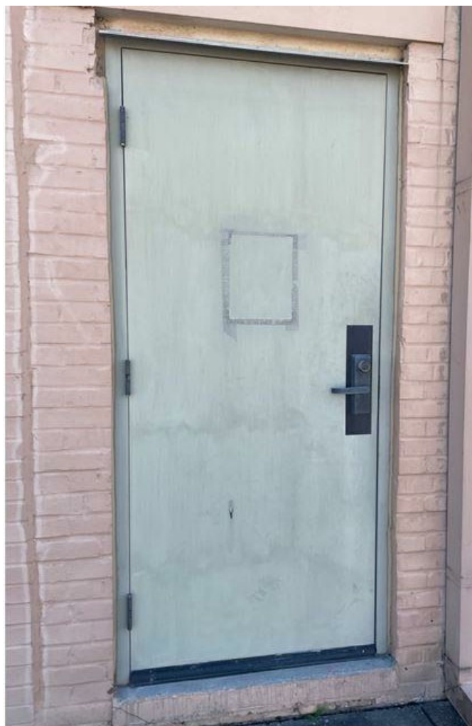
EXISTING SIDE DOOR
