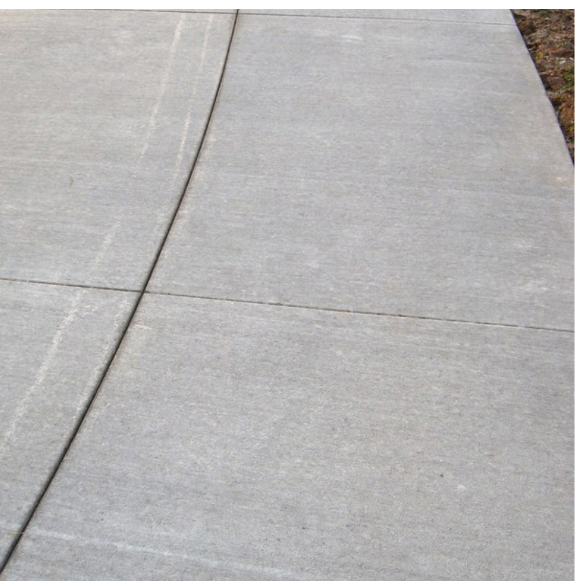
(D) CONCRETE BROOM FINISH
